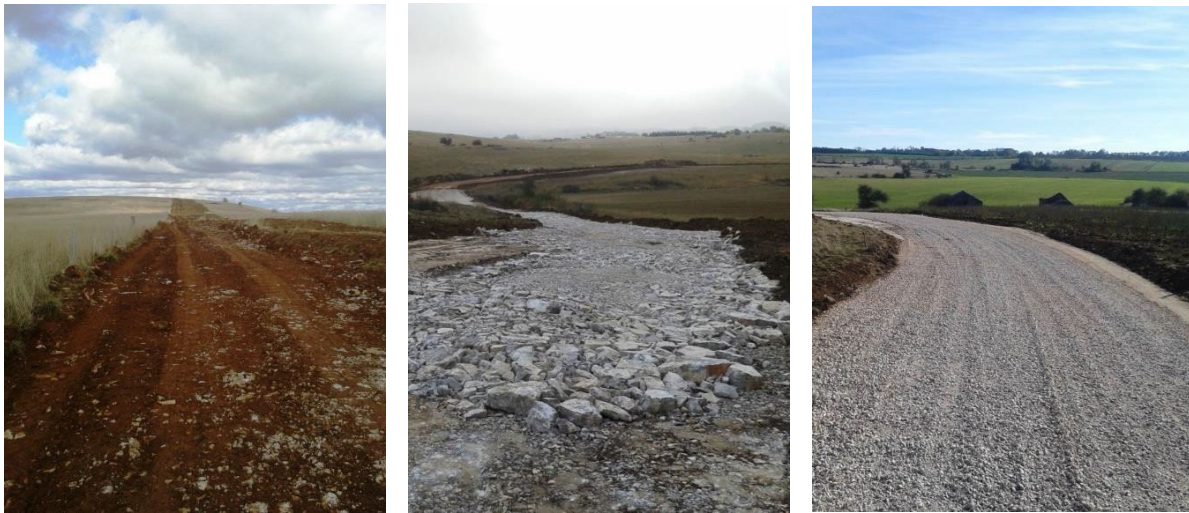
Opération de décapage ; mise en place de la couche de fond de forme ; mise en place de la couche de finition Photos de gauche à droite (Source : Q ENERGY France – Parc éolien de La Baume)
